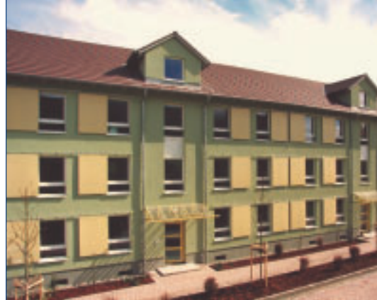
Altbaumodernisierung am Beispiel 3-Liter-Haus.
