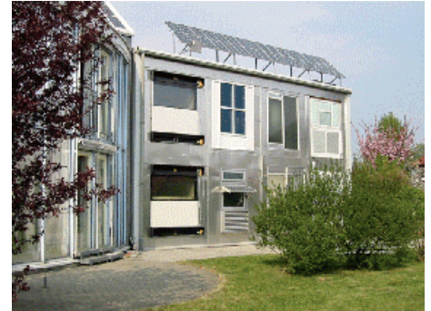
Experimenteller Aufbau zur Charakterisierung von Wandmodulen mit integrierten Phasenwechselmaterialien.
