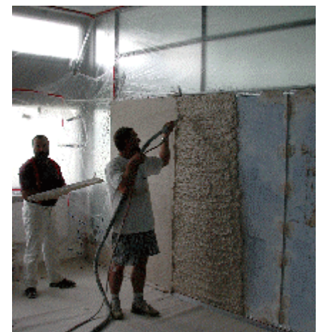
Aufbringen einer Putzschicht, die mikroverkapselte Phasenwechselmaterialien enthält.
